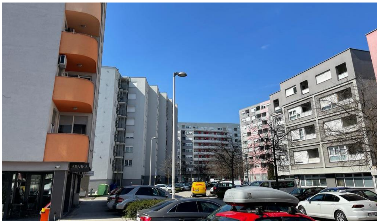
Slika 11. Stambene zgrade u naselju (novoj stambenoj lokaciji) Jaruščica, izvor: autorica
