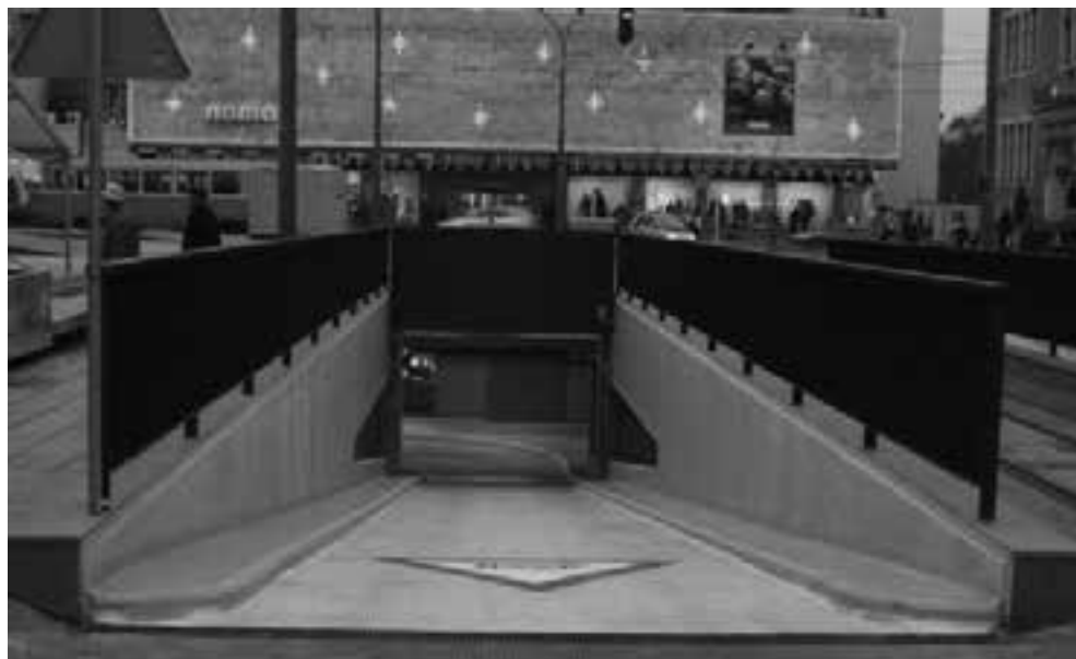
Slika 24. Izlaz iz podzemne garaže kod Kvaternikova trga
