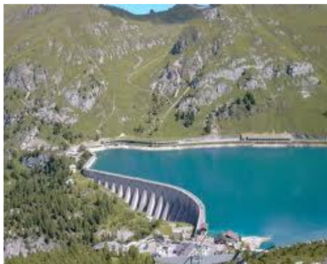
Centrale idroelettrica in Lombardia
