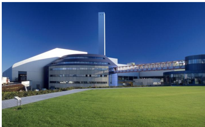
Termovalorizzatore a Brescia
